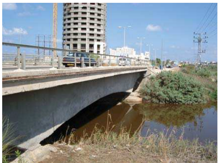
נחל נעמן, דרומית לעכו. יסודות הכביש אינם מותירים כל מעבר מתחתיו, ורציפות התנועה לאורך הנחל נקטעת
