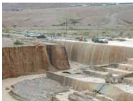
איור 5.5: סחיפת כביש בנחל דרוגות (המקור: אבני וחוברין, המכון הגיאולוגי, GSI/18/2004)
