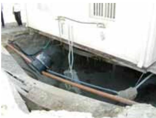
איור 2.3: סולריום עין-גדי, בולענים שנפערו בכביש הגישה לאתר (למעלה) ומתחת למבנה (למטה) (המקור: רז, 2004)
