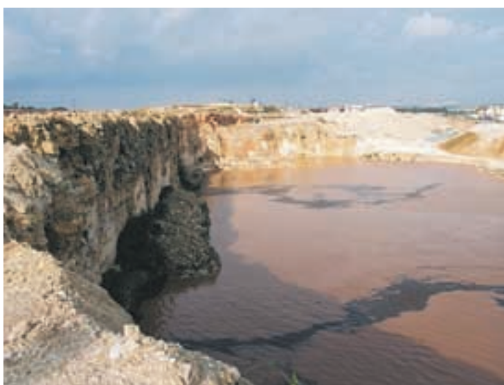
הטיית זרימות נחל שולה למחצבה נטושה, להעשרת מי התהום - שימוש חיובי לשלעצמו במחצבה נטושה בקרבת נחל
