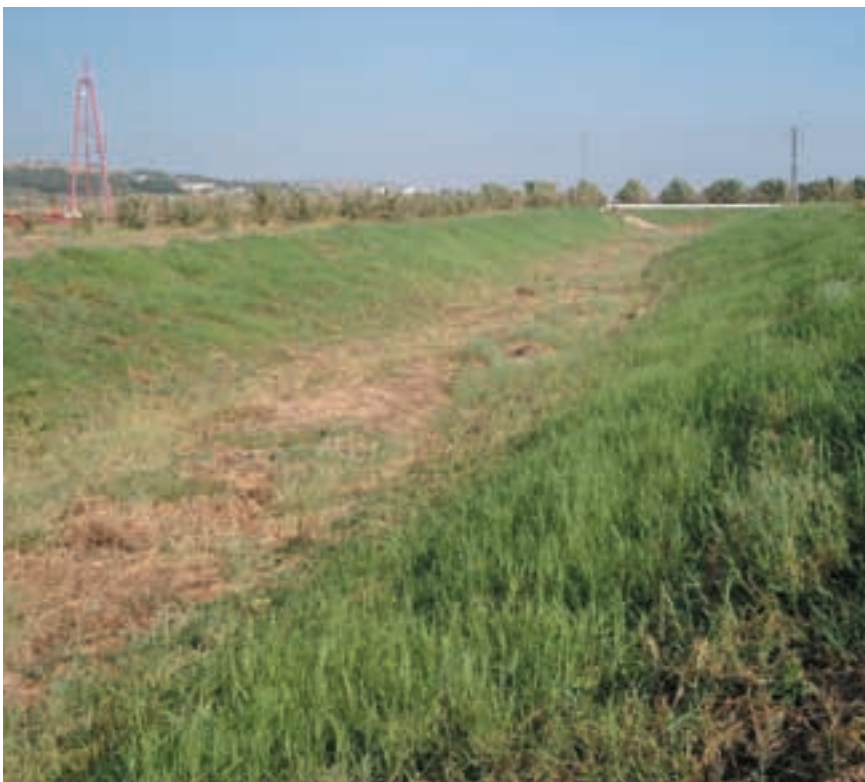
נחל חרוד - תחזוקת גדות, שתילת צמחים בגדות הנחל למניעת סחף קרקע ושמירה על מופע נחל
