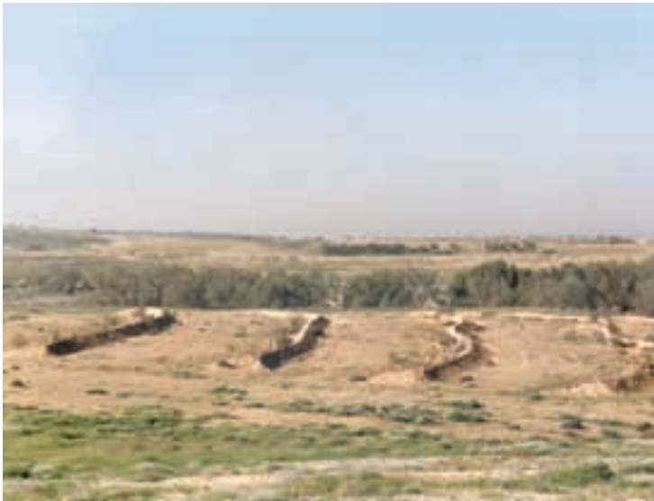
מדרגות עפר - "שיחים" בנחל הבשור, מאיטים את הזרימה ומחזירים את המים לתת-הקרקע
